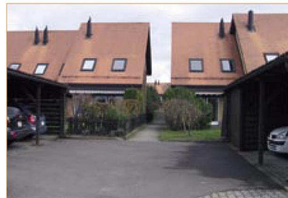
Le regroupement des garages permet de minimiser les nuisances liées à la circulation dans le reste du quartier.
